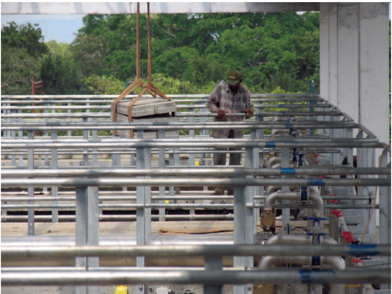
Vattenverksbygge på Sri Lanka.
