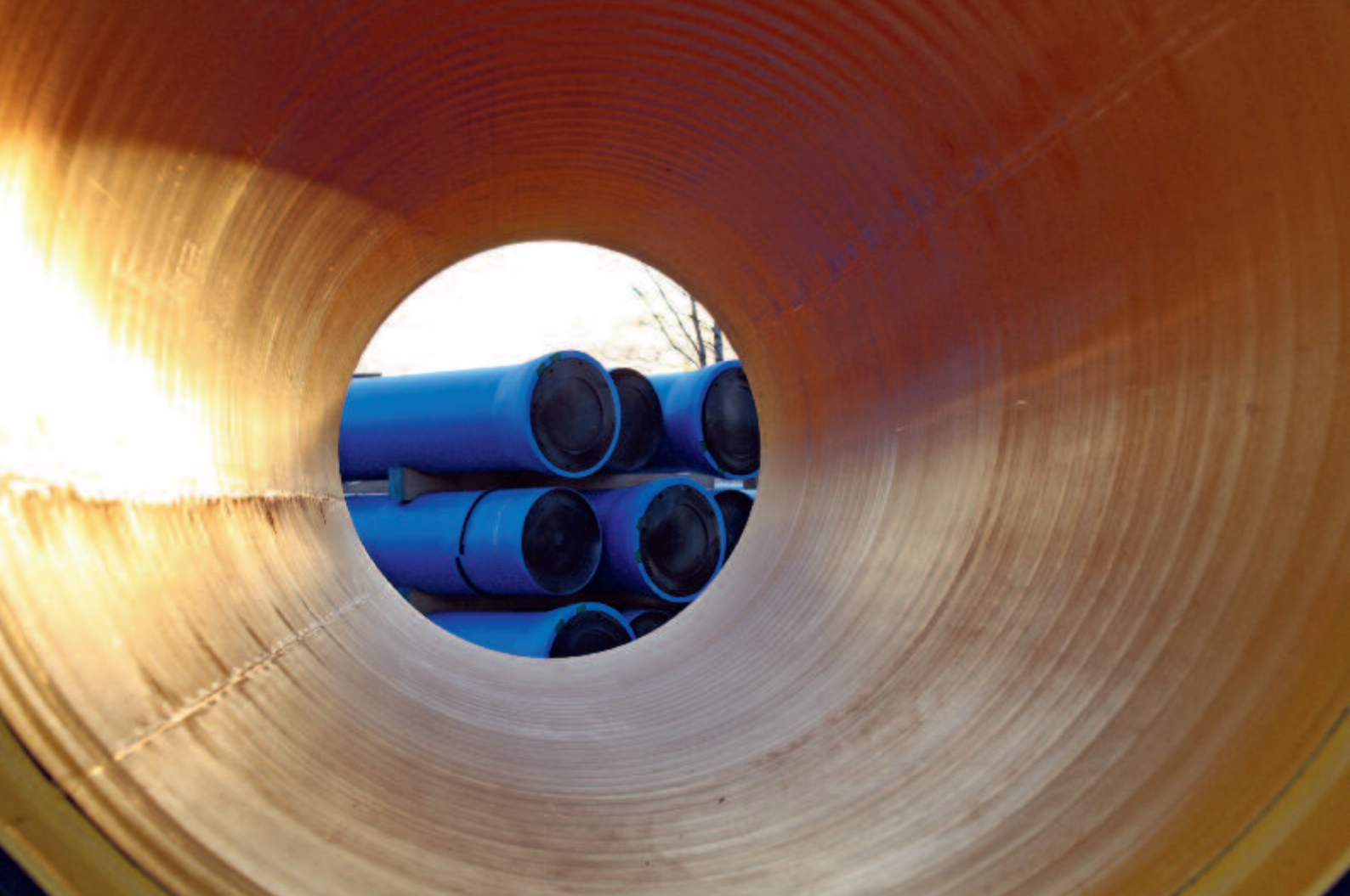
Östra Länken i Luleå, en ny huvudväg för vattnet genom staden.
