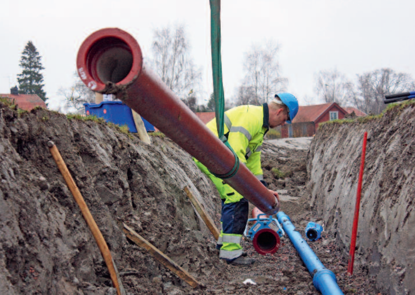
Ledningsbygge utanför Oxelösund.
