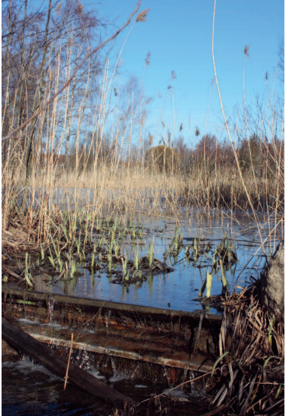
Dagvattendamm i Örebro.
