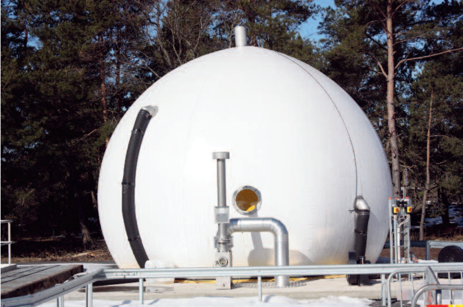
Gasklockan vid Oskarshamns reningsverk.
