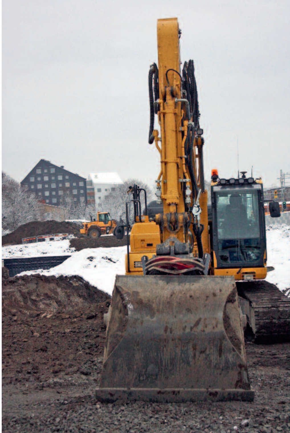
Nordens största kassetmagasin för dagvatten byggdes i Järfälla kommun 2019.
